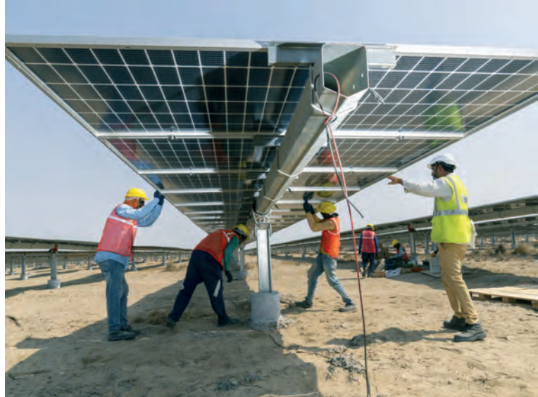
Монтаж солнечных батарей Источник: energyconnects.com
