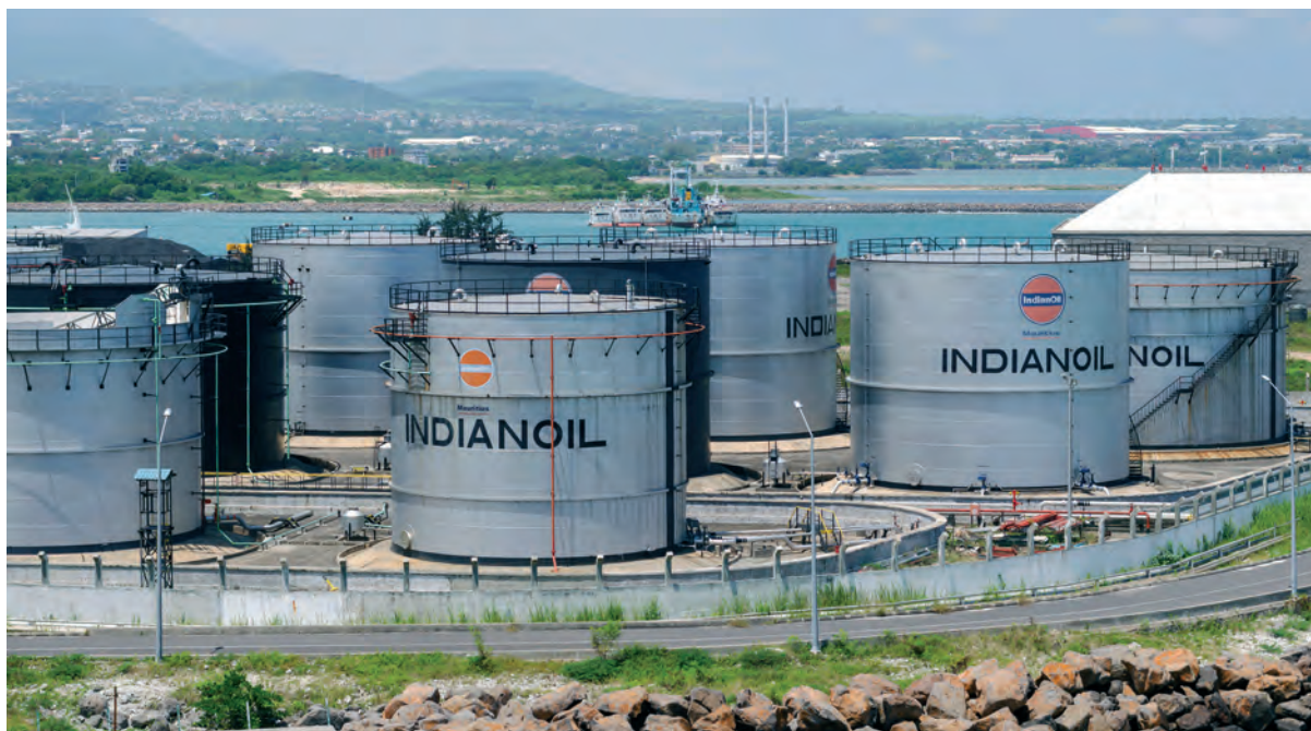
Резервуарный парк Indian Oil на Маврикии
