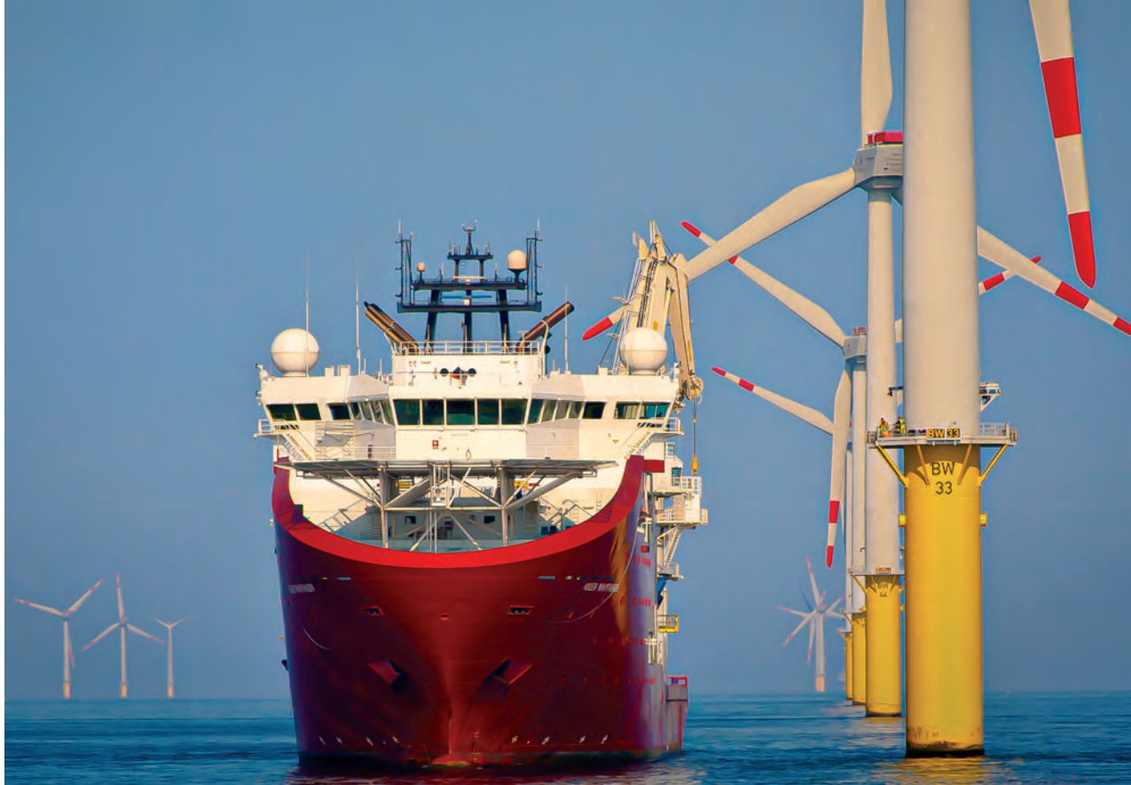
Строительство ветрогенераторов в море
