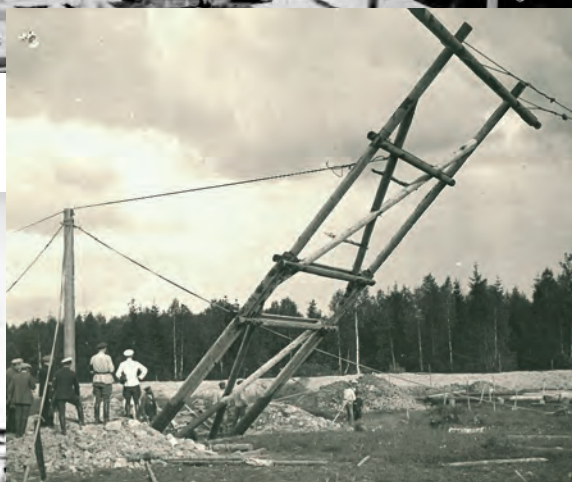
Первые ЛЭП эпохи ГОЭЛРО Источник: «Россети»
