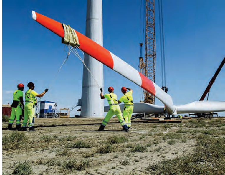
Монтаж ветрогенератора Источник: rosatom-renewables.ru
