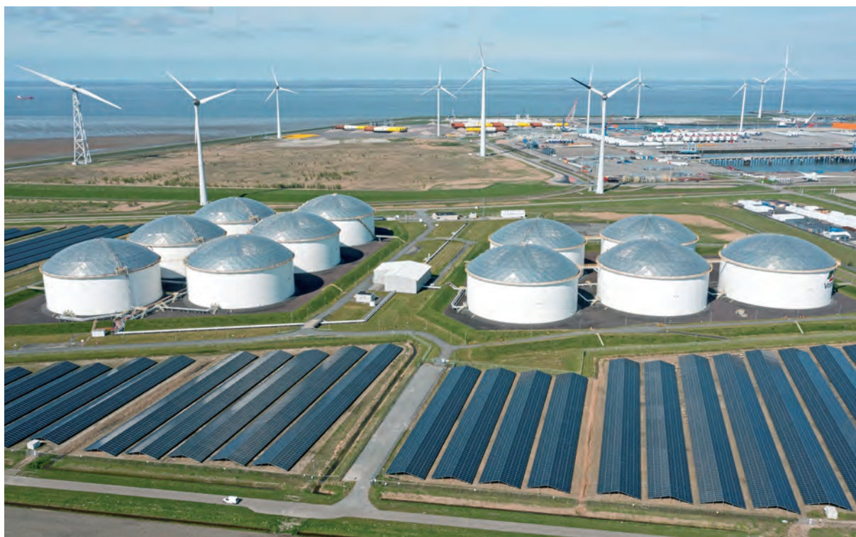
Три источника энергии
