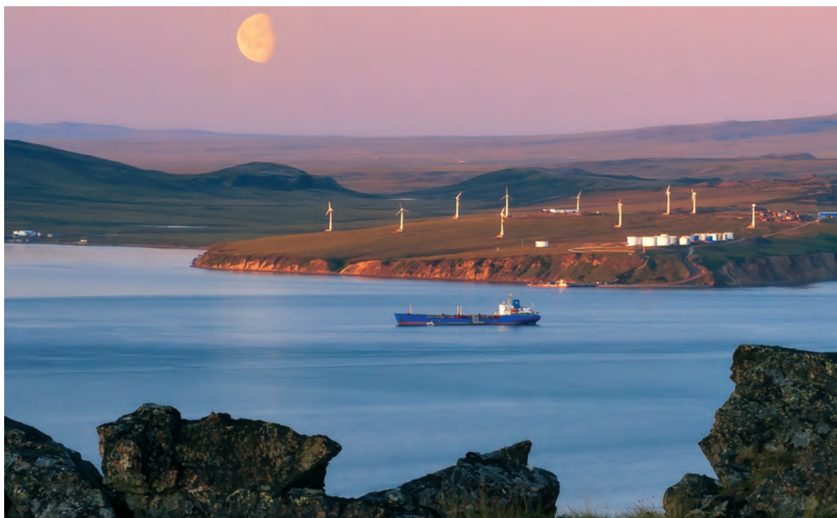
Анадырская ВЭС, Чукотский АО
