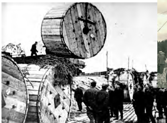
Барaban для кабеля, энергетики во время ВОВ Источник: «Россети»
